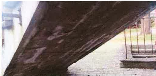
pęknięta płyta schodów bocznych
