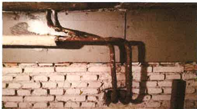
wyeksplotowana instalacja CO
